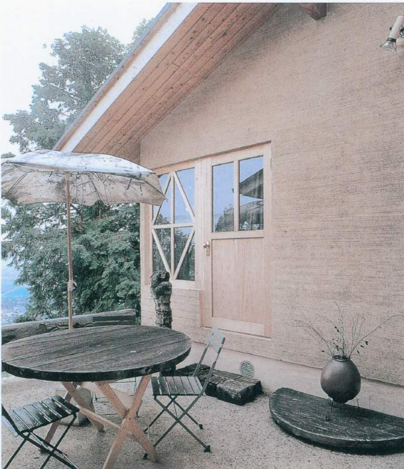
かきおとしによる外壁。
